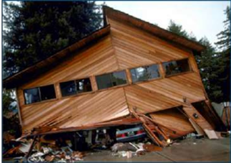
1989 Loma Prieta EQ
