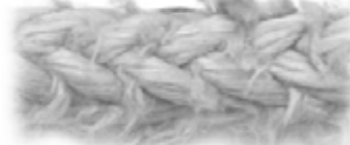
La corde doit être remplacée
