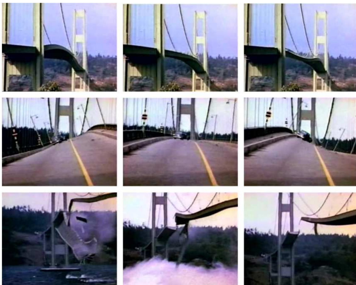
Figura 2.7 – Imagens do colapso da ponte de Tacoma Narrows em 1940
