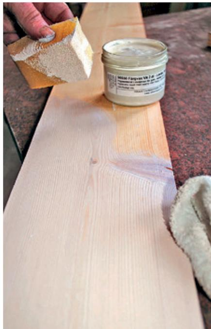
*Appliquer la cire sur des surfaces absorbantes non traitées. Essuyer avec un chiffon sec dans les 20 minutes après l'application.*
