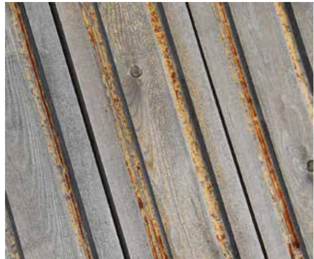
detail of the roof of Byggnadshyttans storage. Photo: Arja Källbom.
