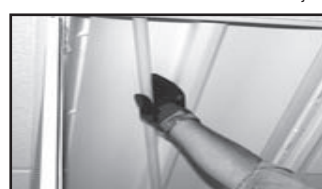
Figura 8. Instalación de las lámparas
