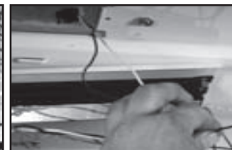
Figure 5. Insertion des fils d'alimentation dans le raccord rapide
