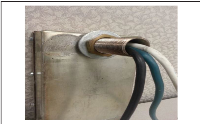
Figure 12. Filtre RF de l'installation EMI
