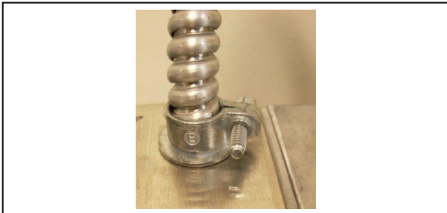
Figura 6. Montaje no ferroso en la caja de conexiones (no reparable por el usuario)
