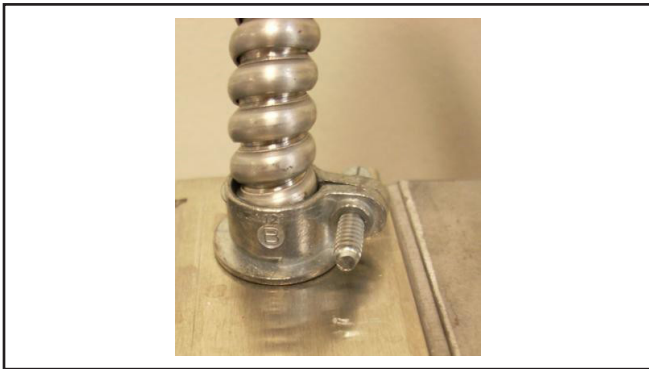
Figure 6. Adaptateur non ferreux sur boîte de jonction (non réparable par l'utilisateur)
