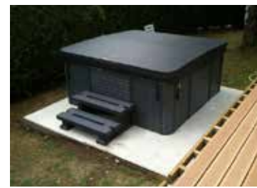
Eine 15cm dicke Betonplatte ist die optimale Unterlage
