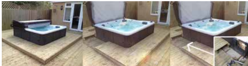
Stellen Sie sicher das jegliche Aussenverkleidung leicht abnehmbar ist um Wartungszugang zu ermöglichen
