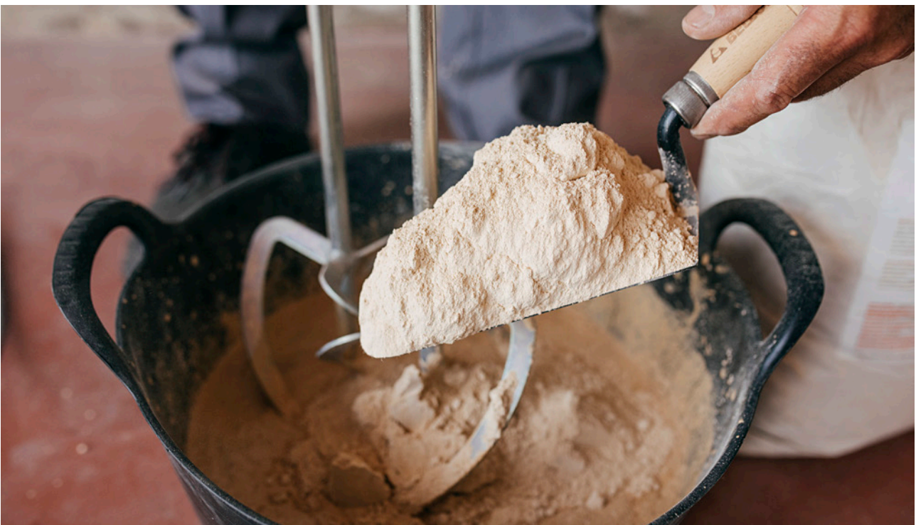
Preparación del adhesivo
