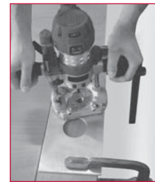
5. Maquinar furações. Drilling machining.
