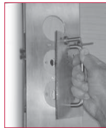
2. Colocar o padrão. Flush application.
