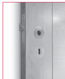
7. Colocação dos espelhos. Escutcheon application.
