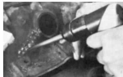
Esta foto muestra una reparación con los tapones instalados y listo para revestir el molde.
