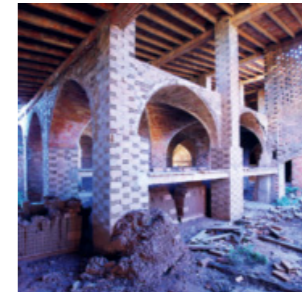
Bóveda de ladrillo. Antigua fábrica de ladrillos Brick vault. Old kiln. Valencia, Spain
