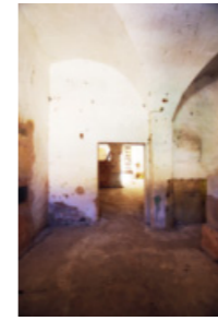
Bóveda de marés. Antigua harinera Marés vault. Four mill. Montuiri, Mallorca
