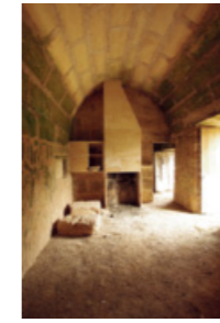
Bóveda de marés. Construcción agrícola Farm building. Llucmajor, Mallorca
