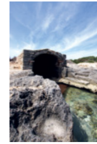
Bóveda de marés. Escar en s'Estalella Marés vault. S'Estanyol, Mallorca
