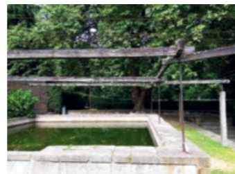
Fernando Távora. Aljibe en Quinta da Conceição Cistern at Quinta da Conceição, Porto, Portugal, 1956-60
