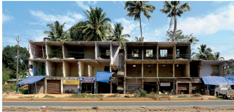
Recorte de edificio para ampliación de carretera Building cut for road widening Thrissur, Kerala, India
