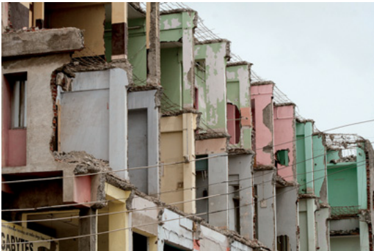
Demolición de edificio para rehabilitación Building being demolished and salvaged Surat, Gujarat, India
