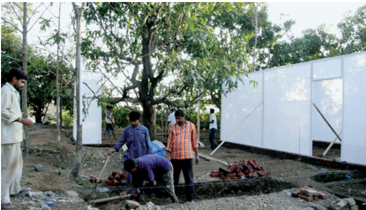
Construcción de maqueta a escala real Construction of full-scale site mock-up
