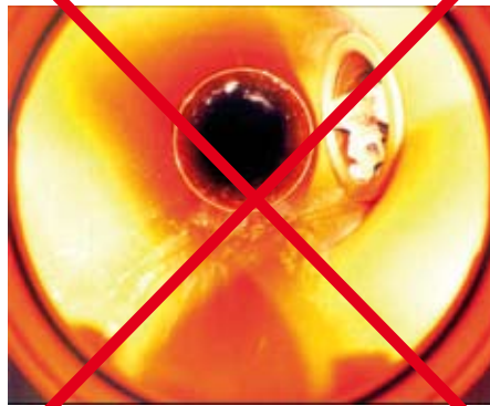
Raccordement non étanche
