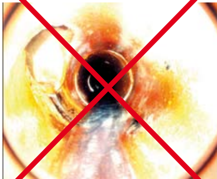
Raccordement par perçage buriné
