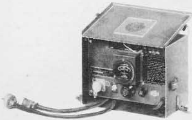
Rectifier Battery Charger PP-116/UPN-1
