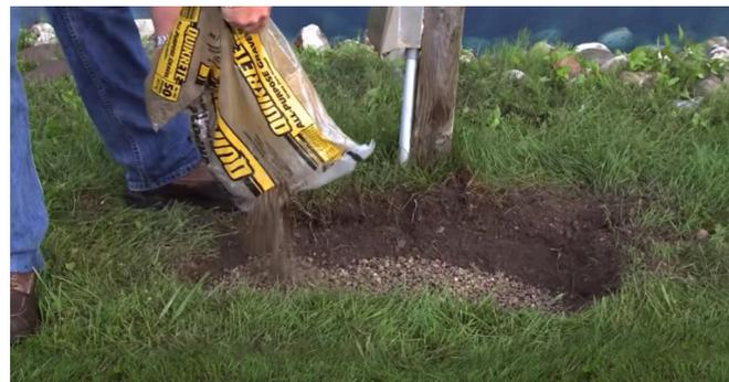
**2.** Mueva el gabinete y eliminar el césped de la zona, rellendo con pequeña piedra o grava. Esto permite una base firme para el gabinete y el drenaje. Abrir el armario de aireación aflojando los 4 tornillos de mariposa. levante suavemente la parte superior del armario y se echó en su lado junto a la base.
