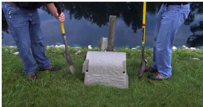
**1.** Coloque el gabinete en el suelo en la ubicación elegida y marca un área de 6" más ancha que la base del armario en todos los lados.
