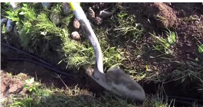
Rellenar la zanja aerolínea en unas pocas áreas para mantener temporalmente la aerolínea en su lugar hasta que se complete la instalación.
