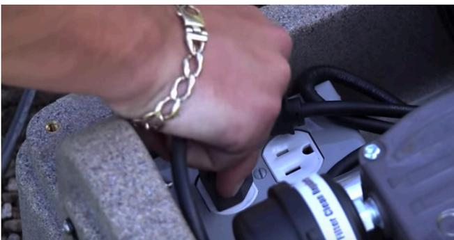
**Sistemas PS10:** Enchufe el compresor y el ventilador de refrigeración en la toma de control de potencia en el interior del armario. Conecte la salida de control de potencia en un tomacorriente GFCI.
