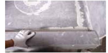
Press the curb
