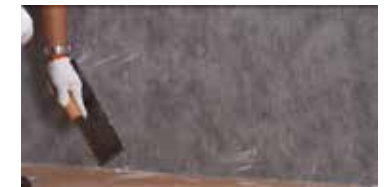
Trim the membrane
