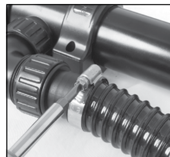
Installation d'un collier de serrage en acier inoxydable
