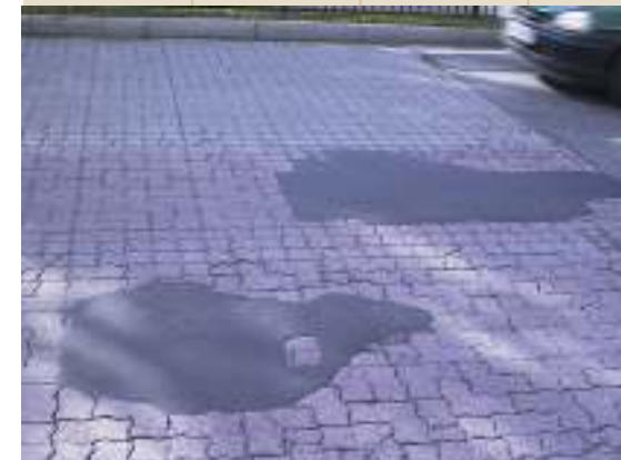
Det finnes gode alternativer til å legge en lapp med asfalt
