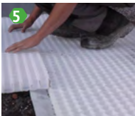
5 installing ECCOgravel®
