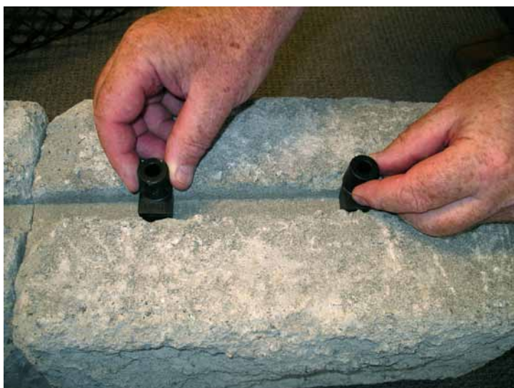
Bilde 3. Montering av låseplugg i hellende mur. Monteres med to stk låseplugg per blokk.
