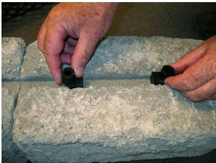
Bilde 2. Montering av låseplugg for vertikal mur. Monteres med to stk låseplugg per blokk.
