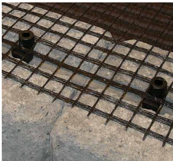
Bilde 4. Montering av geonett på første skift. Monter nettet fast i låsepluggene. Låsepluggene skal stikke opp av tredje raden på nettet slik at så mye som mulig av nettet ligger mellom blokkene uten at det stikker frem på fronten av muren. Det gir best mulig forankring.
