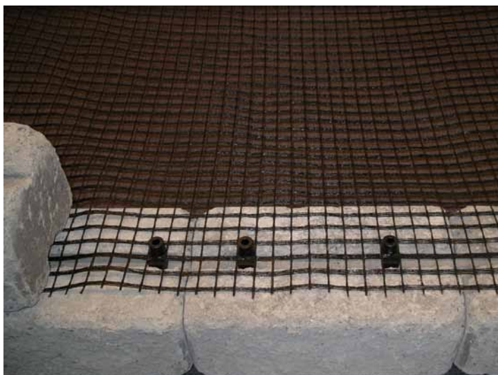
Bilde 4. Montering av geonett på første skift. Monter nettet fast i låsepluggene. Låsepluggene skal stikke opp av tredje raden på nettet slik at så mye som mulig av nettet ligger mellom blokkene uten at det stikker frem på fronten av muren. Det gir best mulig forankring.
