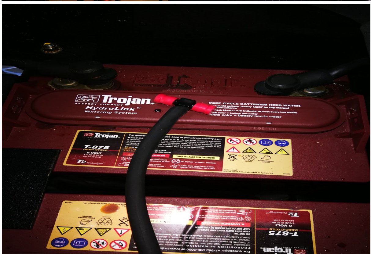
Billede 6-7: Monter de røde gummi studser på slangen hvor der skal lukkes af
