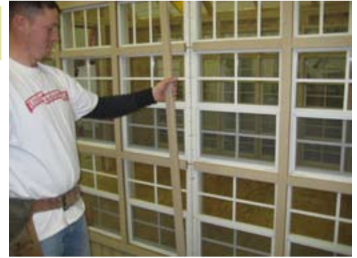
Install window trim.
