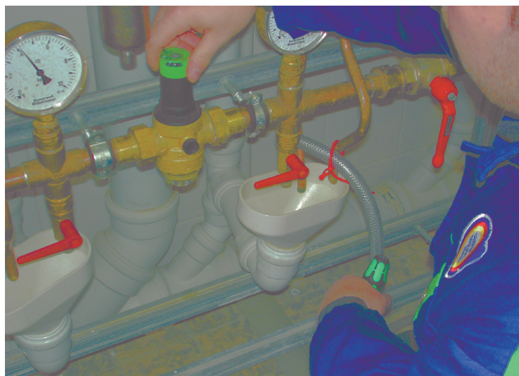
Al termine dell'installazione, è necessario regolare la pressione a valle del riduttore di pressione dell'impianto d'acqua potabile.
