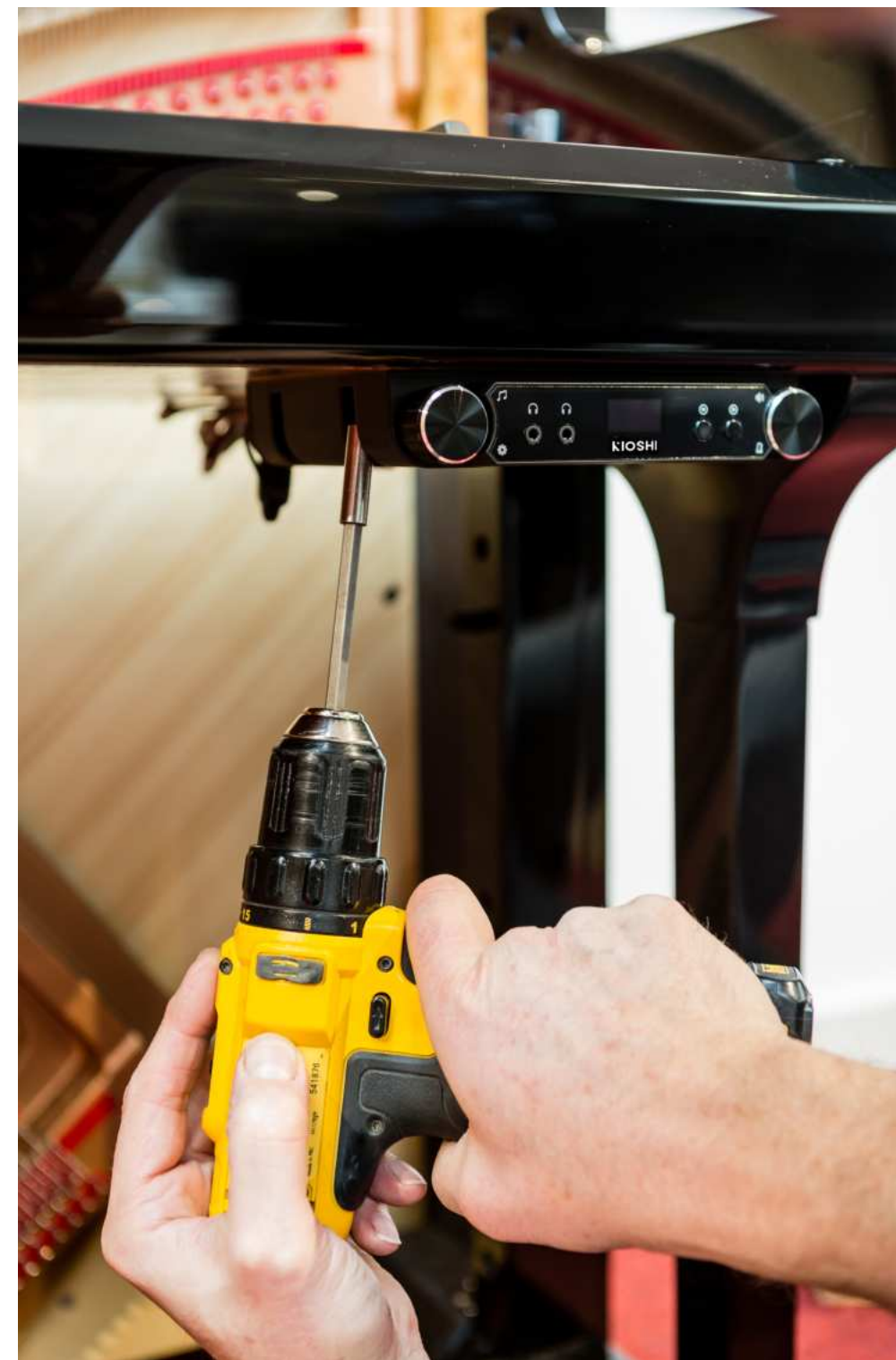
fig. 3.2: Montage van de control box.
