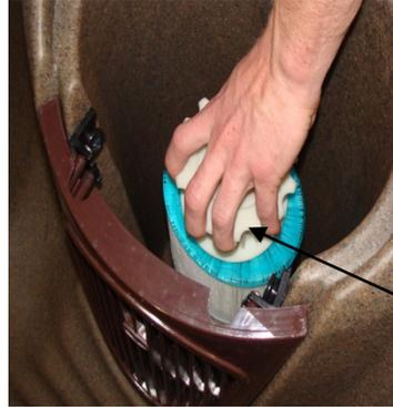
Der automatische Oberflächenfilter des Spas wurde entwickelt, um schwimmende Schmutzpartikel und Verunreinigungen wie Körperlotionen zu entfernen, indem Wasser durch ein speziell gestaltetes Filtermodul gezogen wird. Es ist wichtig, dass dieses Modul regelmäßig gereinigt wird.
