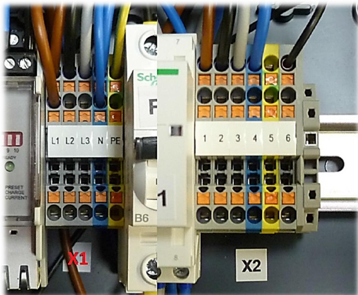
Tilkobling av tilførselskabel og ladekabel: Wallb-eco 2.0 –22kW
