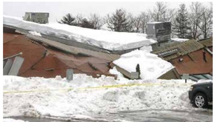
*Edificio que ha colapsado bajo la pesada carga de muchos pies de nieve. Este edificio no pudo mantener su forma bajo el peso de tanta nieve, por lo tanto la estructura falló.*
