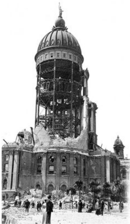
En 1908, San Francisco, en Californie, En 1908, San Francisco, en Californie a subi un très fort tremblement de terre. Le séisme a révélé que les bâtiments dotés de structures internes en acier conservaient leur forme et ne s'effondraient pas. Les bâtiments en brique, en revanche, ont été ébranlés
