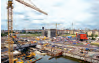
[Abb. 5] Baustelle mit roter Info-Box. Potsdamer Platz Berlin 1996. Fotograf: Michael Westdickenberg. Bild: © Michael Westdickenberg.
