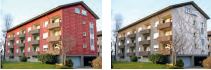
[Abb. 6–7] Gestaltungsvarianten der Fassaden. Bilder: cctp, 2011.
