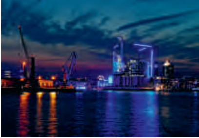
[Abb. 6] Baustelle mit Beleuchtung. Elbphilharmonie HafenCity Hamburg 2011. Fotografin: Angelika Warmuth. Bild: © dpa / Angelika Warmuth.
