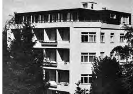
Die Schule für Sozialarbeit Luzern nach dem Umbau der Liegenschaft Hitzlisbergstrasse 5
