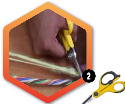
2 Cortar los elementos extra del cable (hilo de desforre, cinta de bloqueo, materiales dieléctricos).
