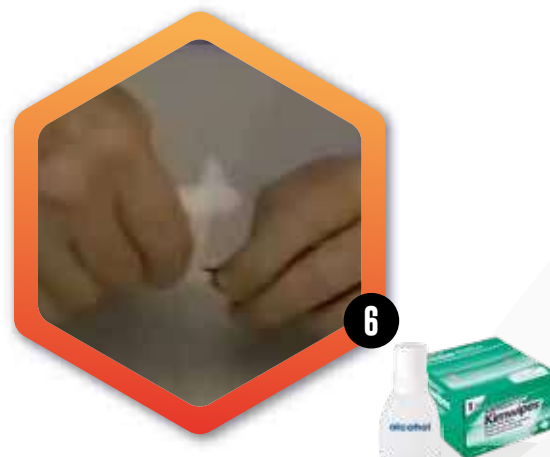
6 Remover el gel de los hilos de fibra óptica.
