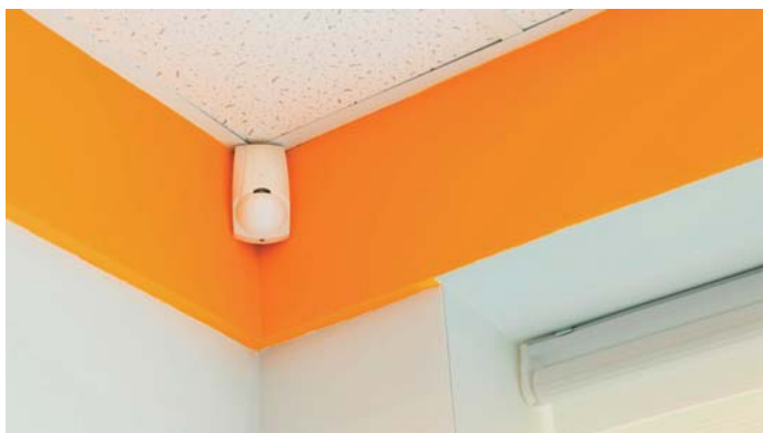
Slika 1-6. Tipičan senzor loma stakla
