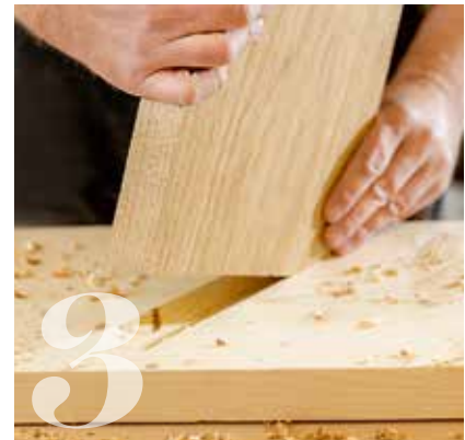
3 Die Stufen werden exakt in die bereits vorbereiteten Wangen eingesetzt
