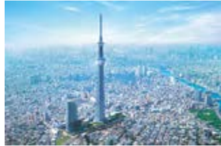
自立式鉄塔としては世界一となる高さ 634m の展望タワー「東京スカイツリー」竣工
