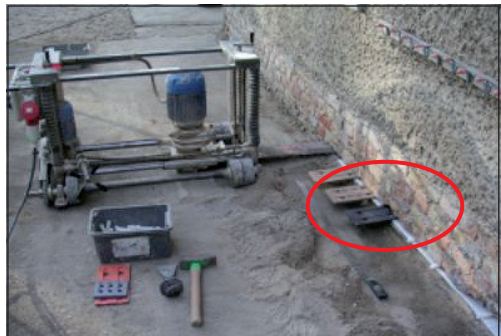
Mauersäge im Einsatz.
