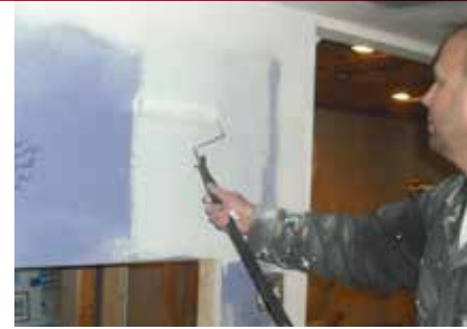
Applying primer to new drywall.
