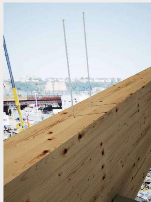
Assemblage à rigidité très élevée de planchers accouplés en CLT. Application avec double inclinaison à 45° idéale pour une réalisation avec un gabarit JIG VGZ.
