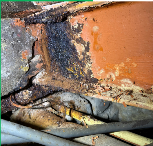
Rotte stalen balk draagmuur
