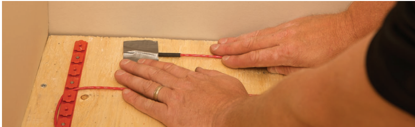
FIGURE 2.28: Fixer l'embout protecteur
