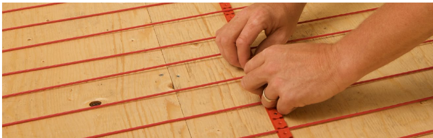
FIGURE 2.29 : Installer les guides de stabilisation
