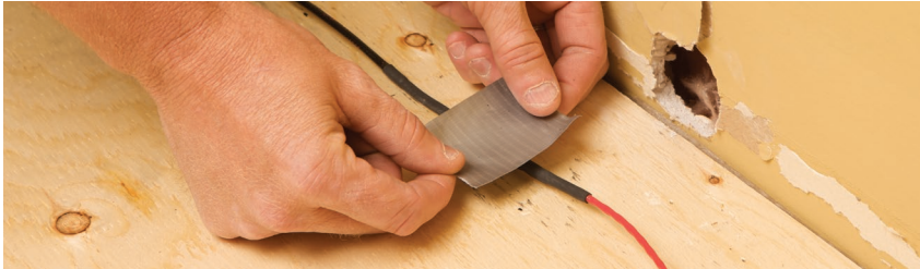
FIGURE 2.23 : Fixer le conducteur froid au faux plancher
