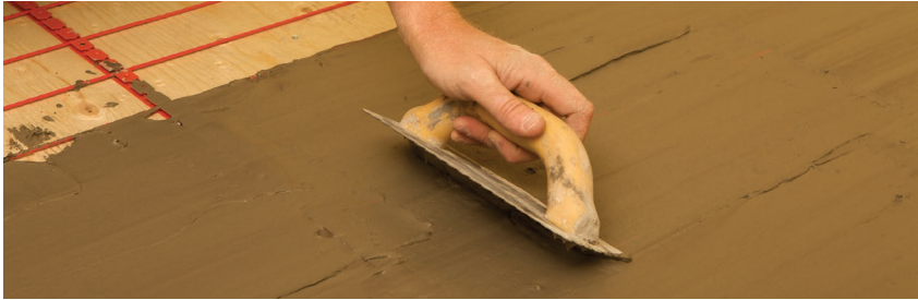
FIGURE 2.52 : Méthode du mortier à pose simplifiée
