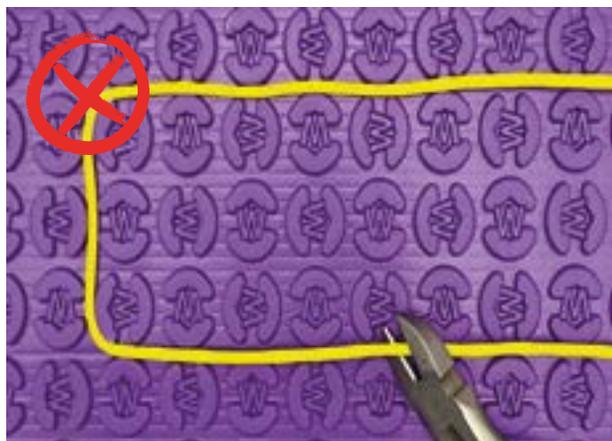
Le câble chauffant ne doit pas être coupé, raccourci, rallongé ou laissé dans un vide. Il doit être entièrement installé dans la couche de thinset ou de composé de nivellement.
