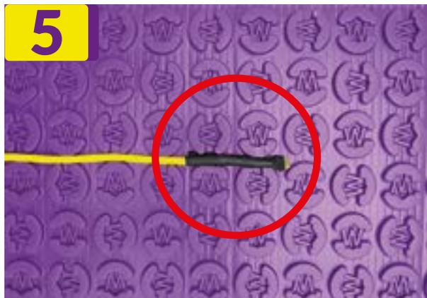
\* A l'extrémité du câble chauffant, vous trouverez un joint de terminaison. Comme le joint fabriqué au début du câble chauffant, ce joint doit être découpé dans la membrane de manière à ce qu'il soit placé à la même hauteur que l'appareil de chauffage.
