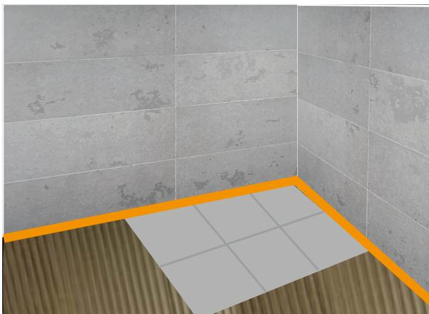
Étape recommandée - Installer des panneaux d'isolation sur le sous-plancher, en suivant les instructions de pose. Il est recommandé d'utiliser des panneaux isolants en polystyrène extrudé, revêtus des deux côtés d'un treillis en fibre de verre noyé dans un mince mortier de ciment-polymère. Ces panneaux contribueront à réduire le temps de chauffage de votre système pour des performances optimales.
