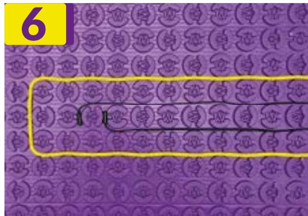
\* Installez le capteur de sol à au moins 6" dans la zone chauffée qu'il contrôlera. Le capteur doit être placé au centre, entre les fils parallèles du câble chauffant, et non dans une zone affectée par d'autres sources de chaleur.
