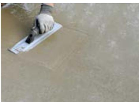
\* Lors de la mise en place de la membrane DrexMat-Heat Peel and Stick, il convient d'appliquer un produit de lissage ou de nivellement approprié sur toutes les surfaces rugueuses.
