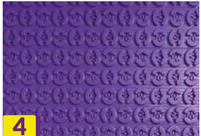
\* Répétez les étapes précédentes pour les passages suivants de la membrane, en joignant étroitement les passages de la membrane jusqu'à ce que la surface du sol soit couverte. Veillez à aligner les chevilles entre les lés de membrane.
