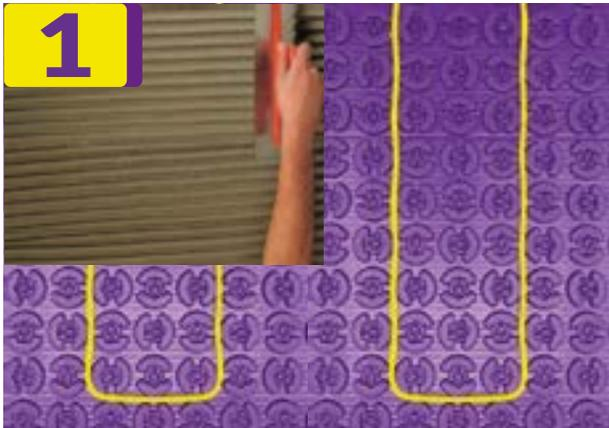
\* Recouvrir l'installation d'une couche complète de ciment-colle modifié, d'une épaisseur minimale de 1/4". Veillez à ne pas endommager ou déplacer le câble chauffant. Si vous utilisez des carreaux dont la longueur ou la largeur est inférieure à 3 1/2", recouvrez d'abord l'installation d'un composé de nivellement.
