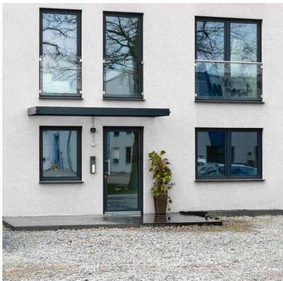
Das Vordach Luis ist dem klassischen gemauerten Vordach nachempfunden: Rechteckige Form in massiver Bauweise und an der Vorderkante mit 1-2 Abläufen für Regenwasser ausgestattet. Luis findet besonders dann Verwendung, wenn ein altes Vordach abgenommen wurde und an derselben Stelle ein Neues angebracht werden soll. Der Rahmen vom Vordach Luis kaschiert die schadhafte Stelle an der Fassade.
