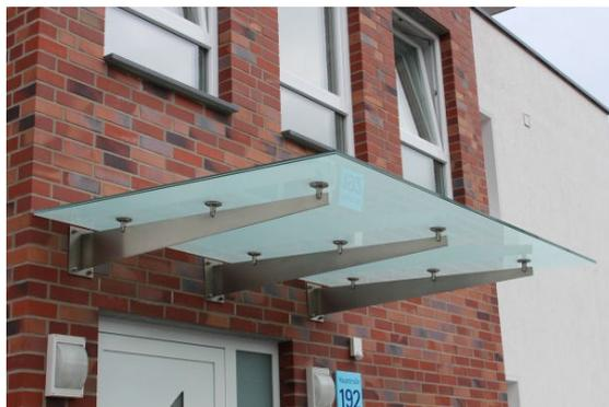
Beim Vordachsystem Espada wird das Glas von unten befestigt. Die Glasscheibe wird mit Glashaltern auf robusten Edelstahl-Schwertern fixiert. Wandseitig werden die Schwerter mit jeweils 4 Schrauben befestigt.
