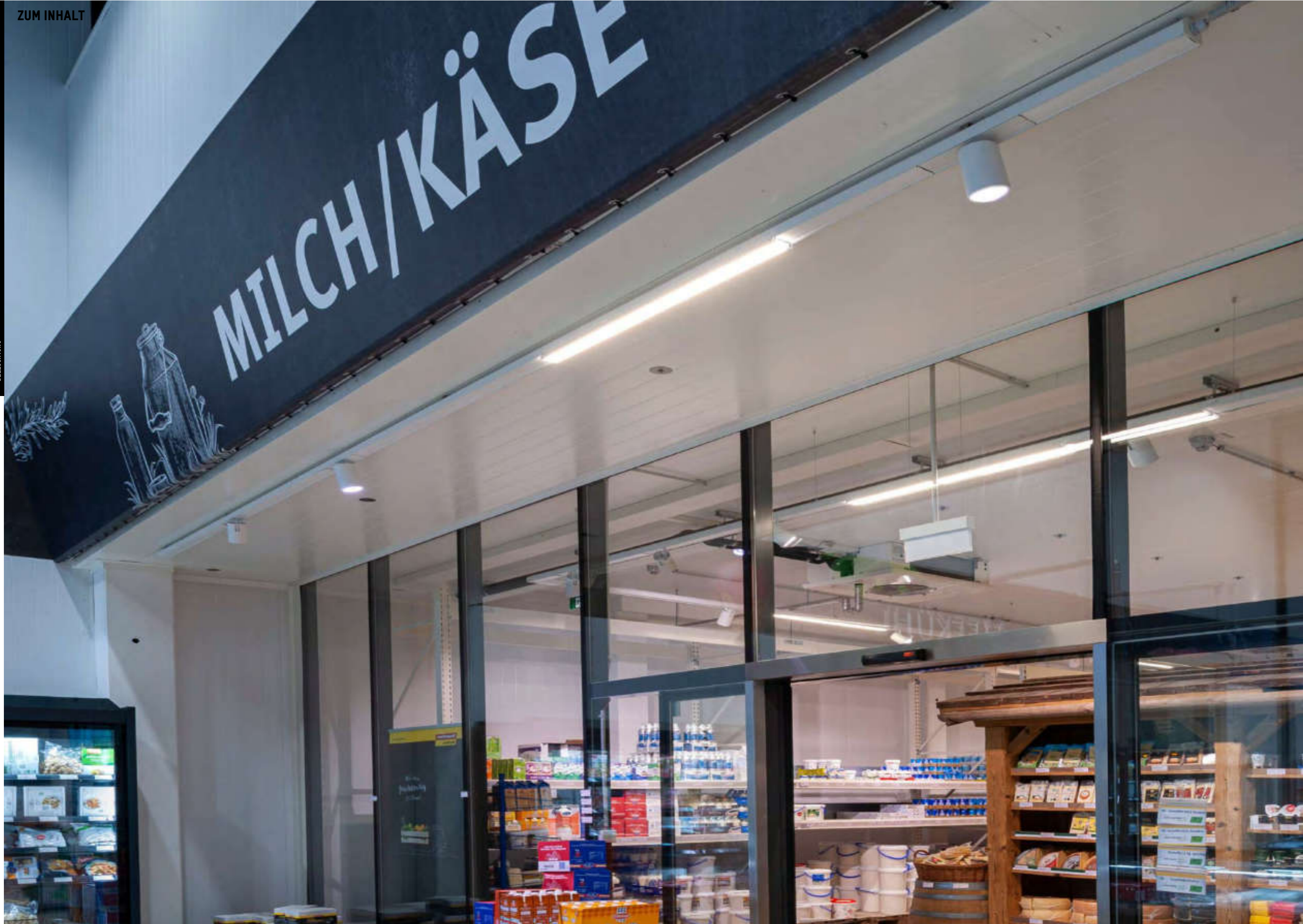
EUROGAST / Leibnitz / Österreich, Verkaufsraum, Akzentbeleuchtung, Montagehöhe: 3,2m, Lichteinsatz Trail Spot, Medium Beam (60°), High Efficiency (HE)
