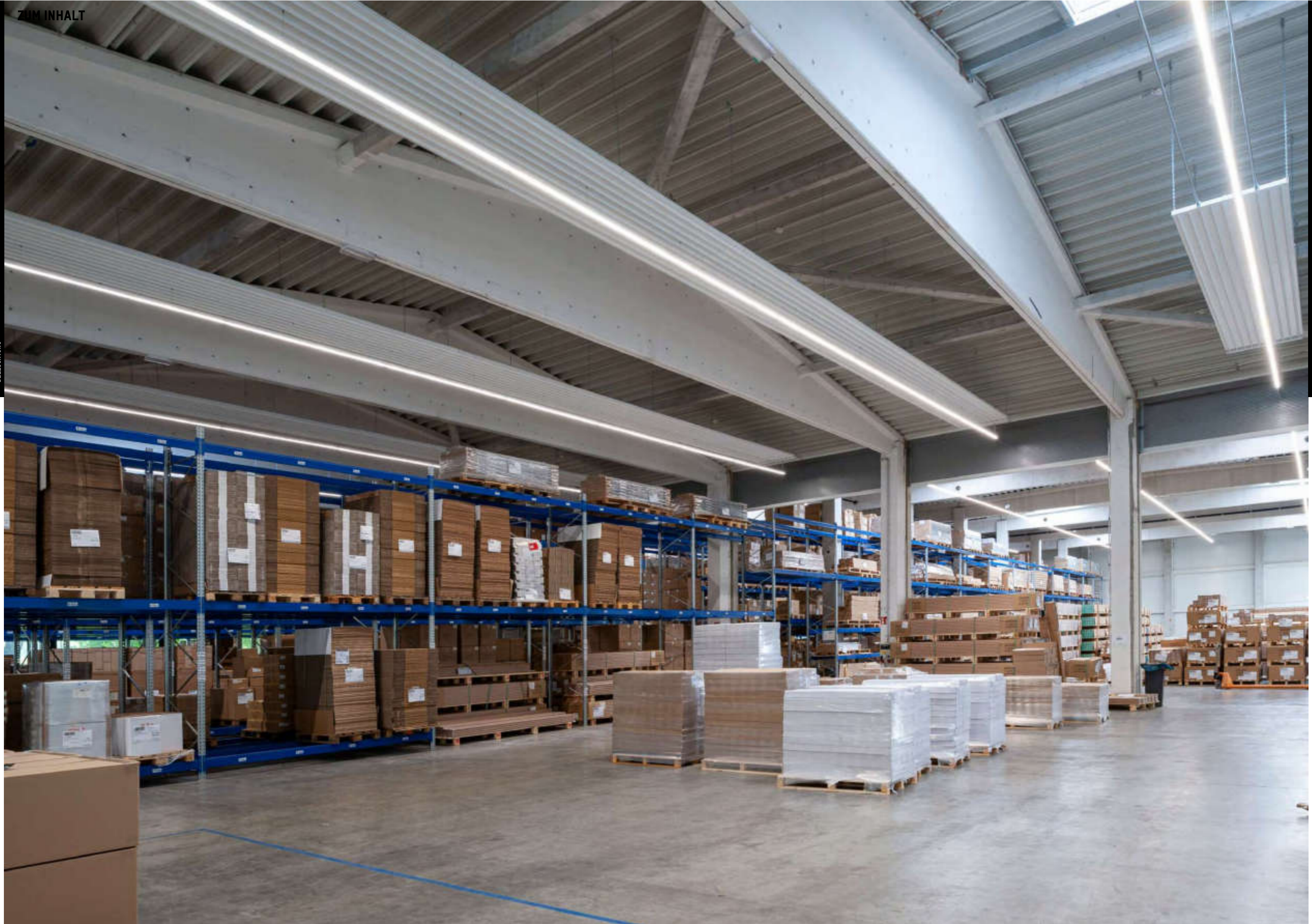
Lagerhalle: 3500m 2 , Montagehöhe: 6m, Installierte Beleuchtungsstärke: 300lx, Trail Lichteinsatz Medium Beam (60°), High Efficiency (HE), DALI
