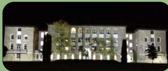
2 lampes de 62W CS Côte-du-Sud (4 étages et 250' de large)
