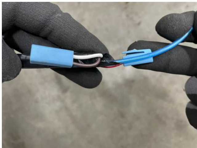
Abbildung 7: Befestigung der Steckanschlüsse an der Einziehhilfe
