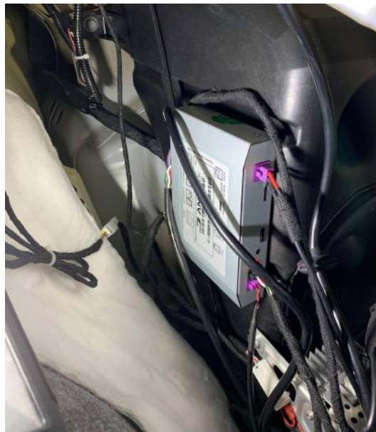
Abbildung 29: Anbringung der zentralen Steuereinheit
