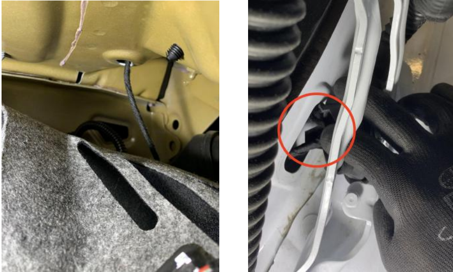
Abbildung 11: Durchführung durch die Karosserie im Kofferraum (links) und die Kabelführung (rechts)
