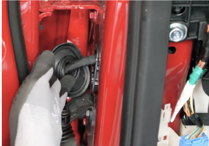
Abbildung 32: Lösen des Kabelschlauchs
