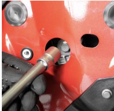
Abbildung 9: Entfernen der Schrauben in der Fensterfassung
