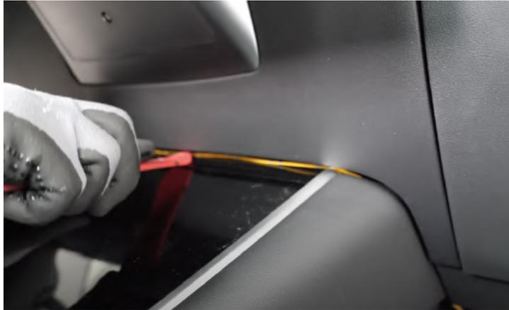
Abbildung 39: Führung des Stromkabels auf die rechte Fahrzeugseite
