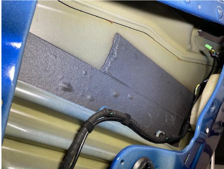
Abbildung 61: Kabelführung hintere Tür (2)
