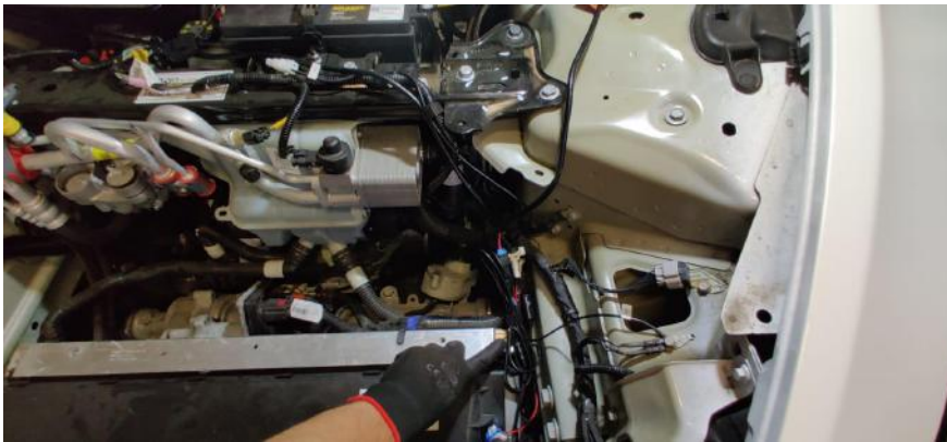
Abbildung 24: Kabelführung und Kabelfixierung
